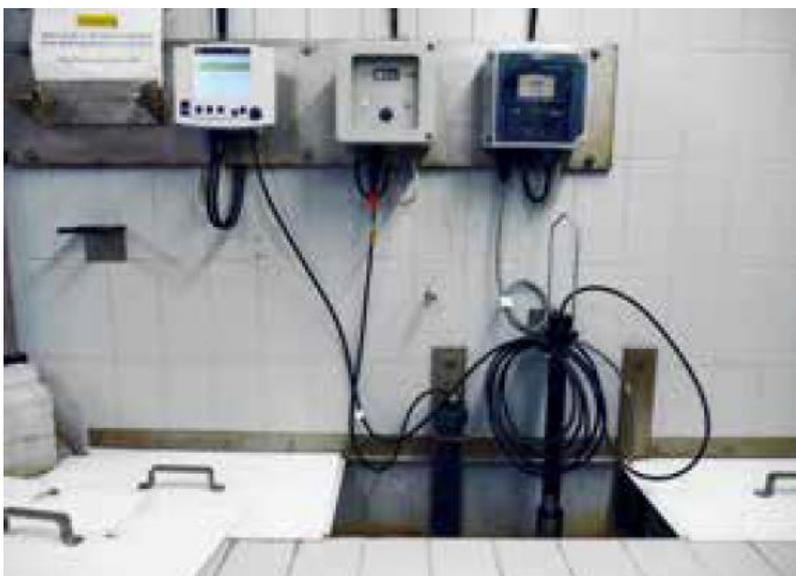
Installation des spektralen Sensors (unten rechts) mit dem Controller MIQ/TC 2020 XT (oben links).
